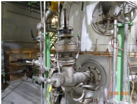
ภาพที่ 2.2-2 การติดตั้ง Low NO x Burner บริเวณเตาหลอม
