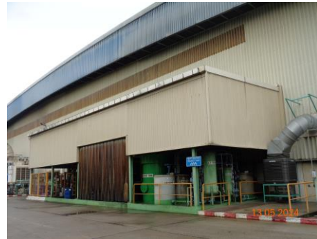
ภาพที่ 2.2-8 ระบบบำบัดน้ำเสียทางเคมีเบื้องต้น (Chemical Treatment)
