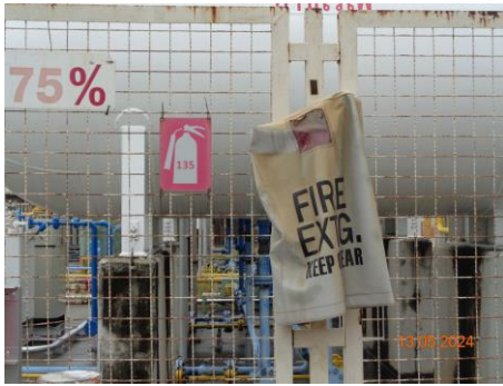
ภาพที่ 2.2-44 การติดตั้งถังดับเพลิงผงเคมีแห้ง บริเวณลานถังเก็บ LPG
