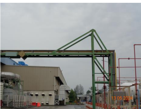
ภาพที่ 2.2-40 การยกระดับแนวท่อ LPG ให้สูงจากระดับพื้น
