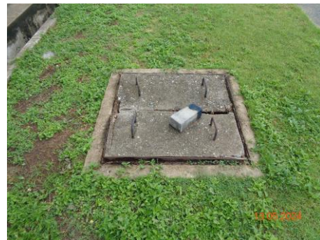
ภาพที่ 2.2-10 ถังดักไขมัน (Grease Trap)
